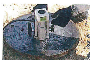
STEP 2 柱の水平方向誤差0
